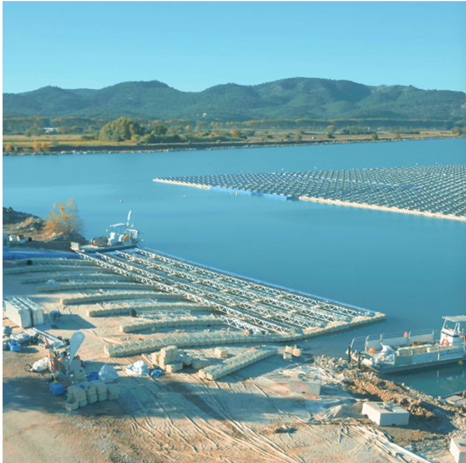
6.3 pav. 14,7 MW plūduriuojanti saulės elektrinė Prancūzijos Peyrolles, nebe eksploatuojamam karjere
