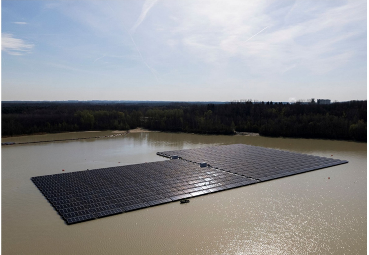
6.2 pav. 3 MW plūduriuojanti saulės elektrinė Vokietijos Quartzwerke karjero tvenkinyje) [7]
